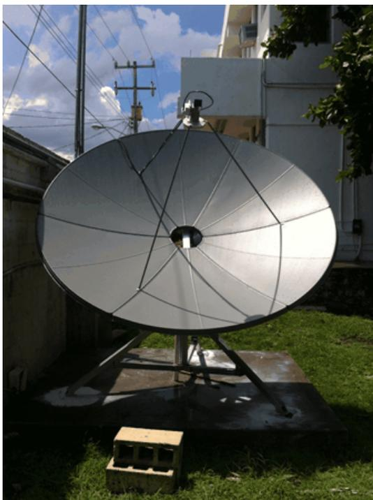
Antena de Mérida, Yucatán, la cual recibe datos del sistema GNC-A. Angulo de polarización =  $-53.8^\circ$
