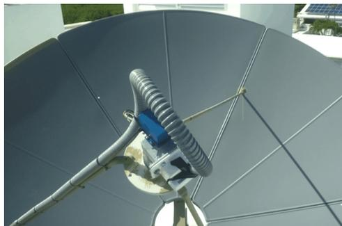
Antena de la UNAM, la cual no estaba recibiendo datos del sistema GNC-A. Angulo de polarización =  $-51.7^\circ$
