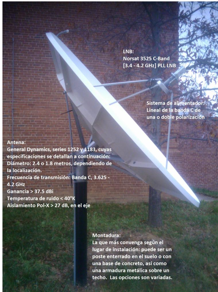
En la figura anterior se describen los componentes utilizados en la antena que se muestra, la cual se utilizó como base para el desarrollo del manual de instalación de la página web de GEONETCast. Estos componentes se refieren a una antena específica instalada en Silver Spring, Maryland y pueden variar significativamente de una estación a otra, ya que no se puede hablar de una antena única de GEONETCast.
