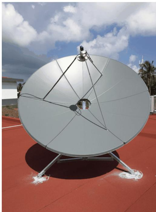
Antena de Veracruz, la cual no recibe datos del sistema GNC-A. Angulo de polarización =  $-60.6^\circ$
