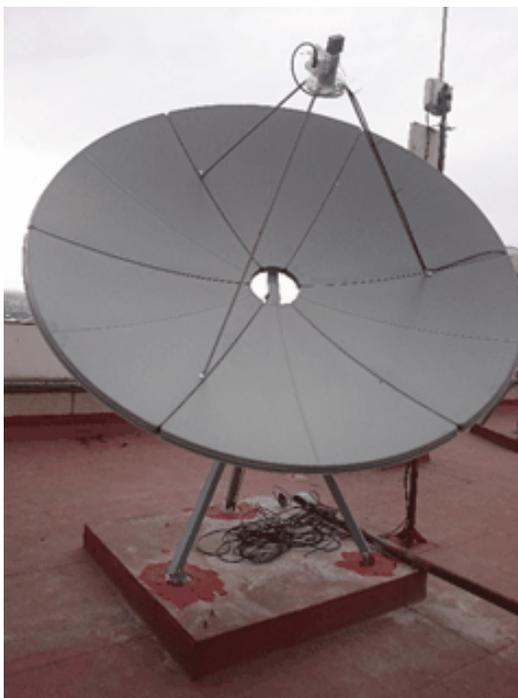
Antena de CONAGUA, la cual recibe datos del sistema GNC-A. Angulo de polarización =  $-61.8^\circ$
